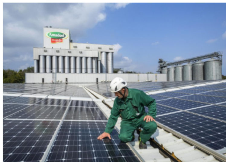
Pannelli fotovoltaici da Amadori
